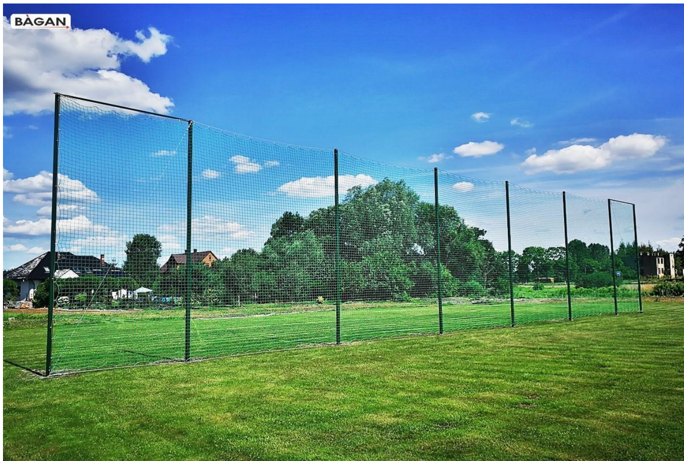
Budowa piłkochwytów na boisku treningowym
