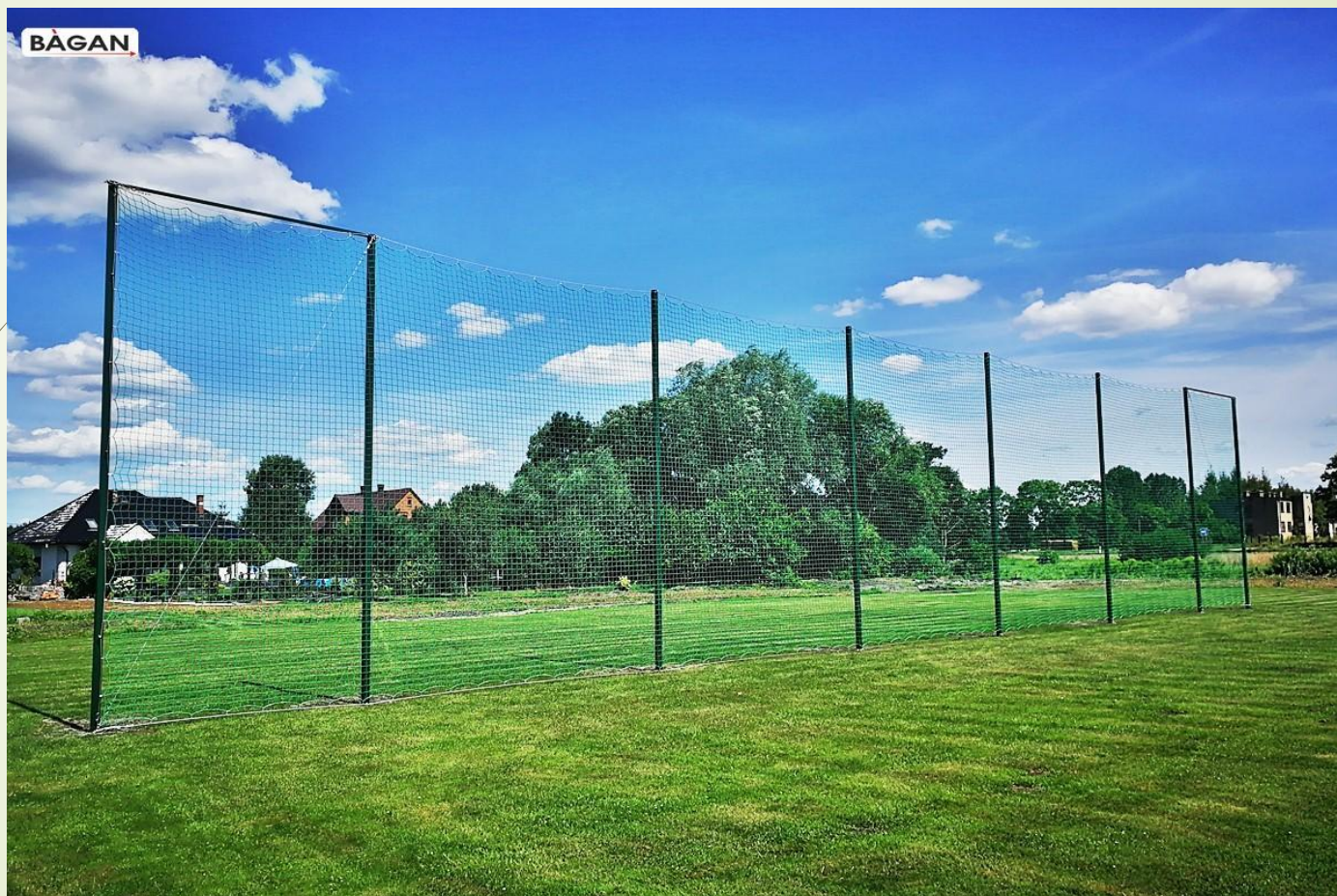
Budowa piłkochwyłów na boisku treningowym
